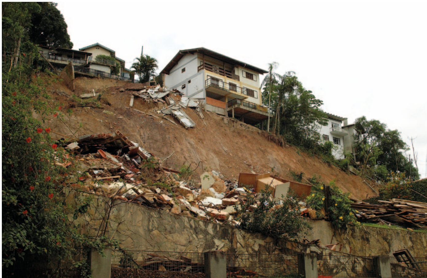
Retirar a vegetação e ocupar as encostas íngremes e topos de morro aumenta os riscos de deslizamentos e enchentes. Na foto, deslizamento em Blumenau - SC (2008).
